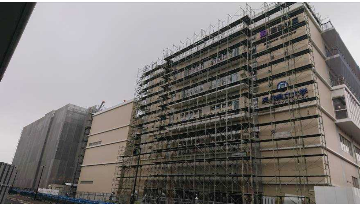
教育研修棟工事風景
