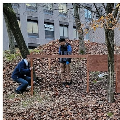
腐葉土を作成のための 木枠を製作中
