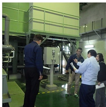
下水処理場視察
