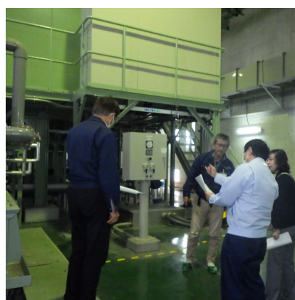
下水処理場視察
