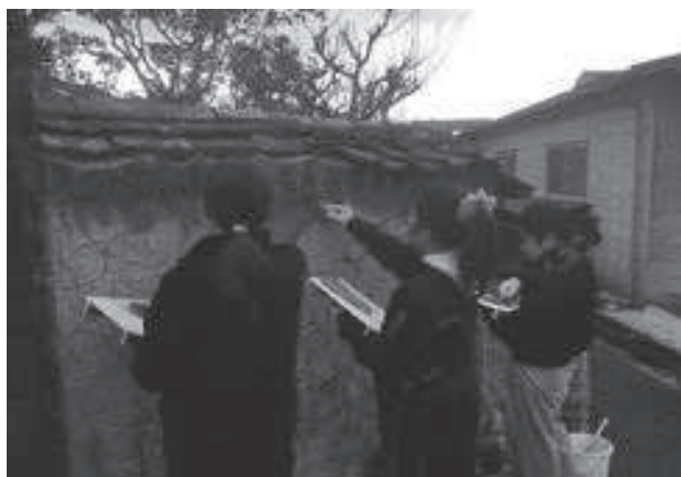
図 1：土壁を修復している場面 土壁ワークショップ 2021
