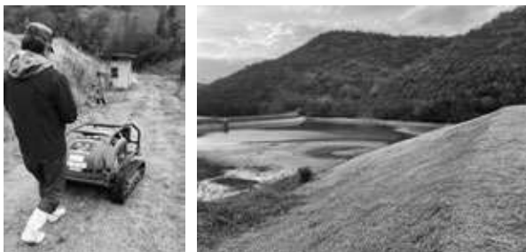
写真 1 ラジコン草刈機の使用時と実施後の様子
