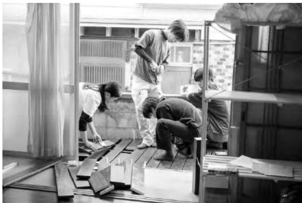
写真 2 ウッドデッキを組み立てる様子
