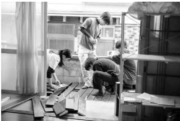
写真 2 ウッドデッキを組み立てる様子
